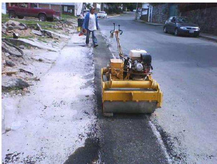
*Figura 4.13.h. Reposición de pavimento de asfalto y limpieza.*
