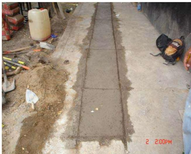
*Figura 4.13.g. Reposición de pavimento de concreto y limpieza.*
