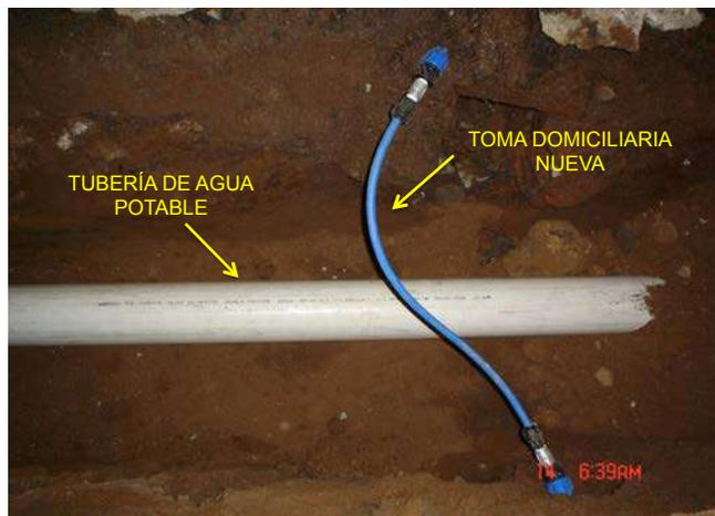
*Figura 4.10.d. Reposición de una conexión domiciliaria afectada.*
