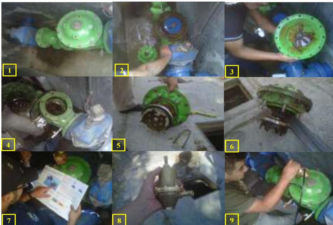
Figura 5-28. Inspección, desarme y limpieza de una válvula automática reductora de presión expuesta a vandalismo y falta de mantenimiento.
