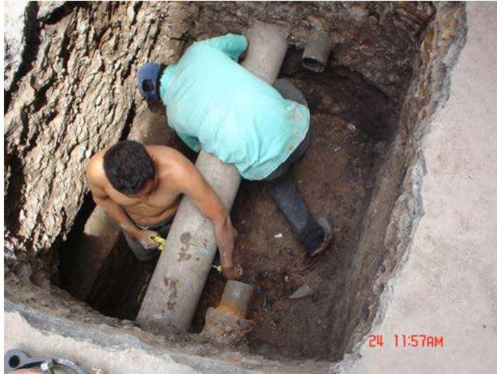
*Figura 4.11.d. Corte de tuberías.*
