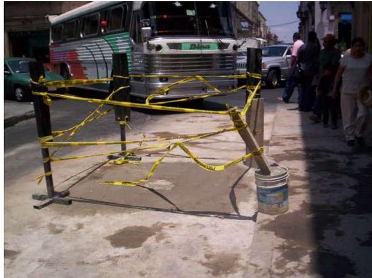
*Figura 4.11.i. Colado de losa, reposición de pavimento y limpieza.*
