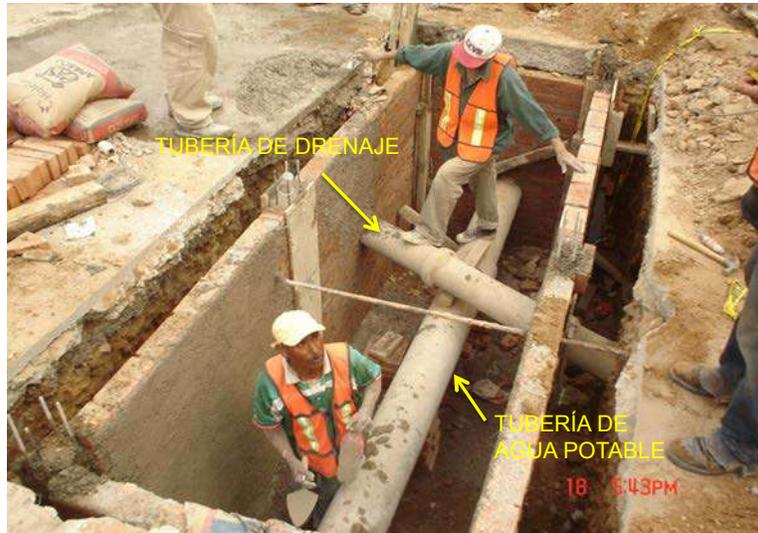
*Figura 4.10.a. Tubería de drenaje atravesando una estación de medición.*
