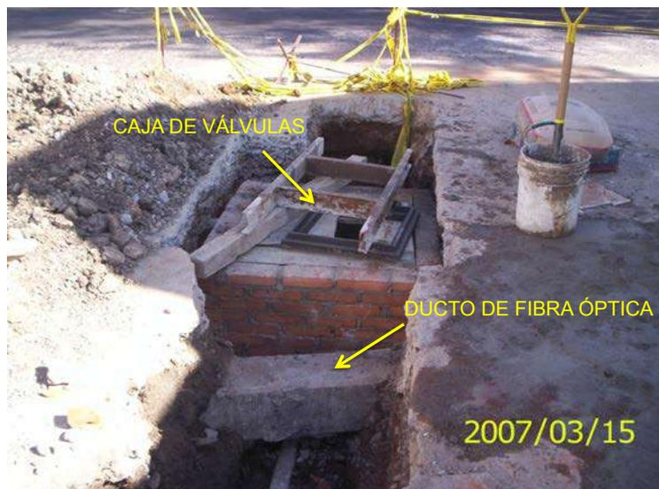
*Figura 4.10.b. Ducto de fibra óptica justo a un costado de una caja de válvulas.*
