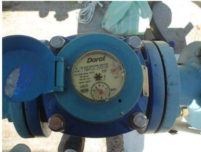
*Figura 4-20. Medidor observado en campo que tiene en su cuerpo el modelo, marca y la capacidad.*
