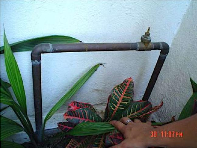
Figura 2-41. Toma domiciliaria sin micromedidor para registro del volumen de consumo (cuota fija).
