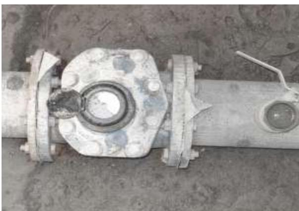
*Figura 5.31.a. Medidor con azolve.*
