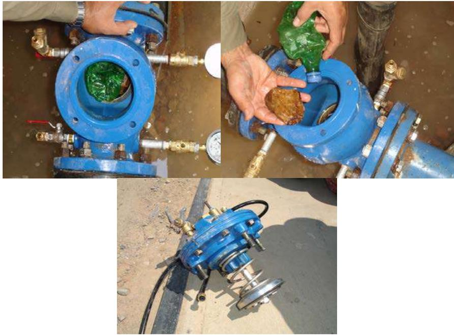
Figura 5-27. Inspección, desarme y limpieza de una válvula automática reductora de presión debida a una obstrucción.
