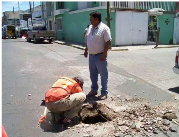
*Figura 4.1.a. Caja de válvulas tapada por reposición de pavimento.*
