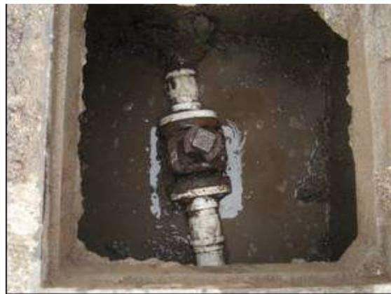
Fotografía de la válvula después de desazolvar
