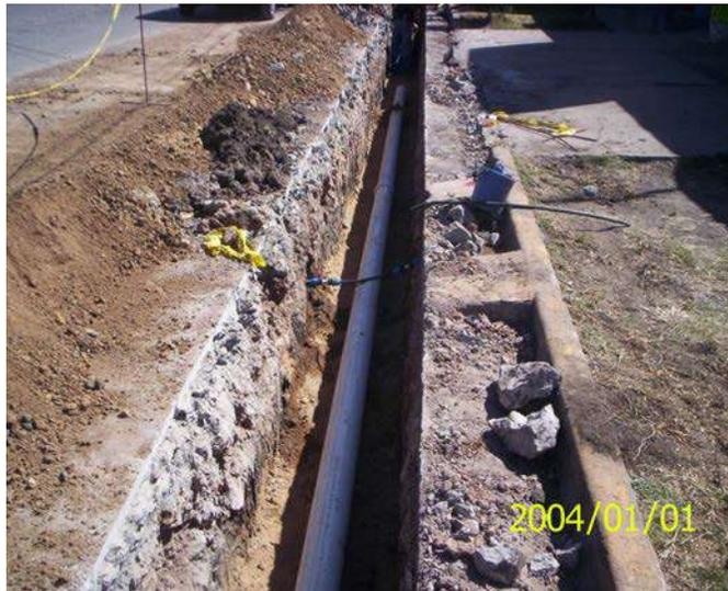
*Figura 4.13.d. Tendido de tubería.*
