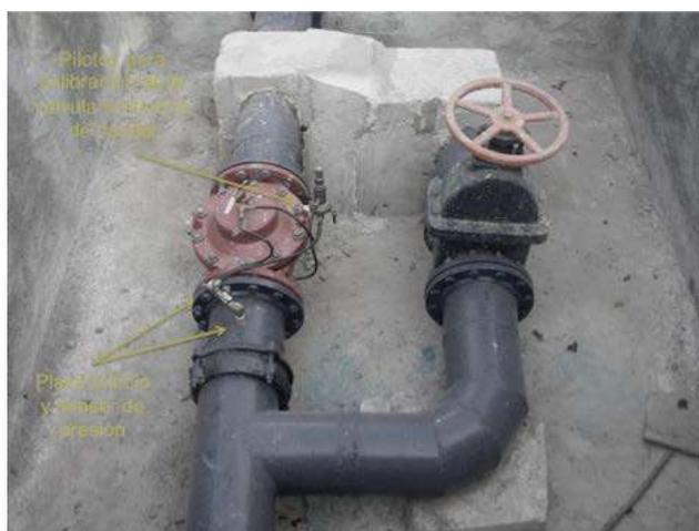
Figura 4-30. Válvula limitadora de caudal instalada en tubería de 10 pulgadas de diámetro.
