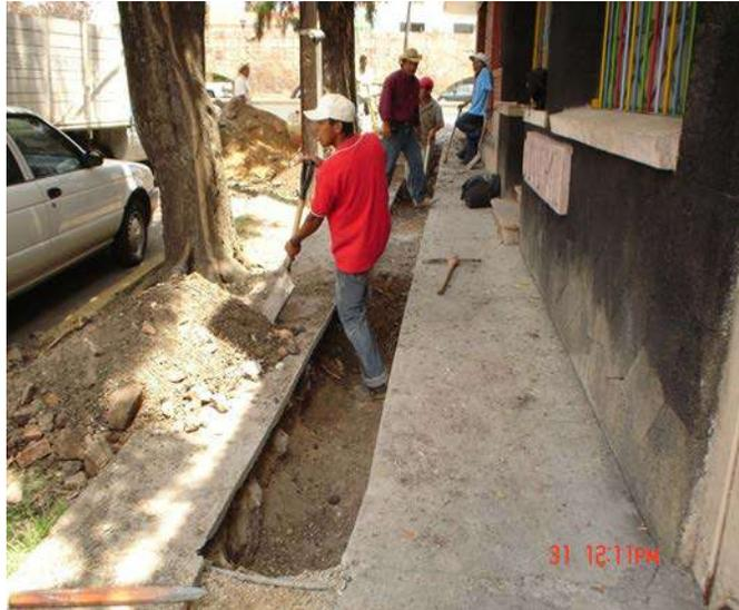
*Figura 4.13.b. Excavación de zanja a mano.*
