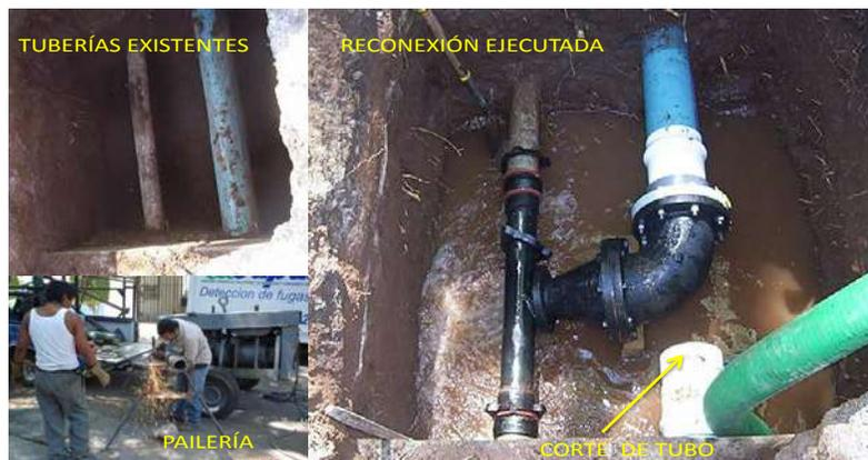
Figura 4-15. Ejemplo de reconexión de tubería de ocho a cuatro pulgadas para derivar caudal hacia otra zona.
