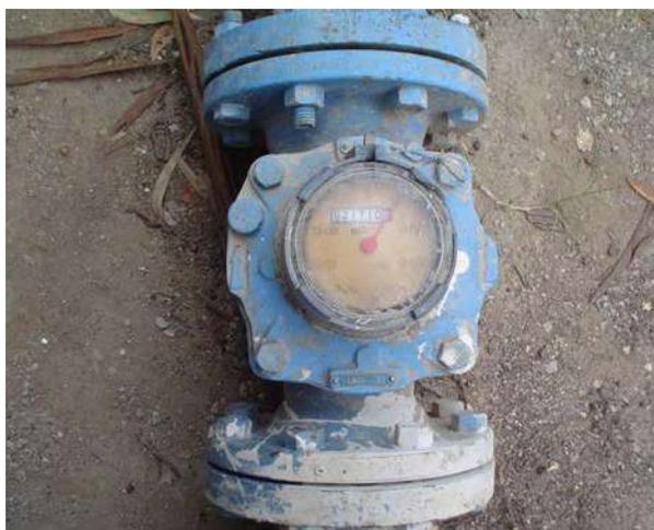
*Figura 5.31.b. Medidor sin caja, protección ni carátula.*
