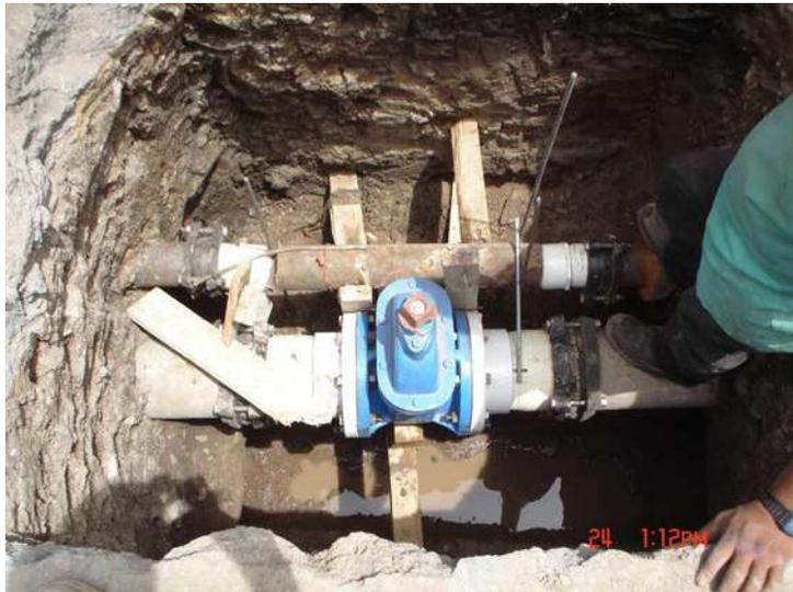
*Figura 4.11.e. Montaje de válvula.*
