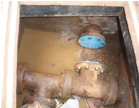
*Figura 4.12.a. Corte de tuberías con tapas ciegas en los extremos.*
