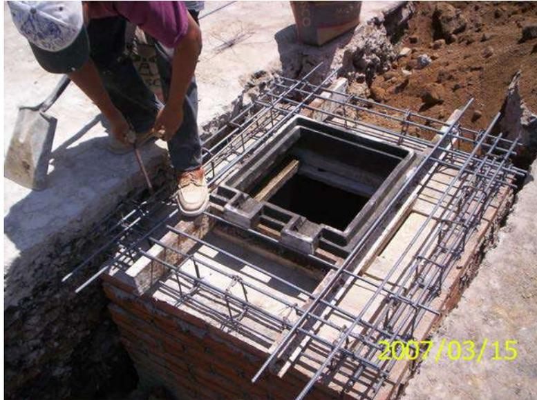
*Figura 4.11.g. Cimbrado y armado de losa y colocación de marco para tapa.*
