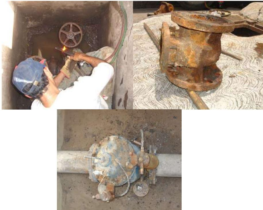
*Figura 5-29. Válvulas de compuerta y reductora de presión, deterioradas por la falta de mantenimiento.*
