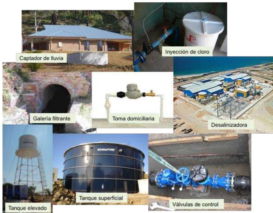
Figura 1-2. Algunas obras de infraestructura de los sistemas de abastecimiento de agua potable.
