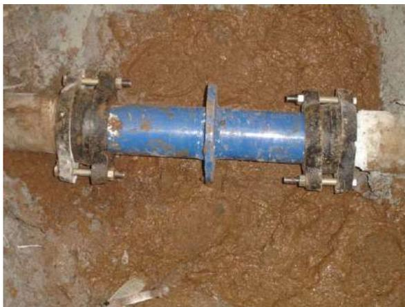
*Figura 4.12.b. Corte de tubería con carrete ciego unidos con juntas Gibault.*
