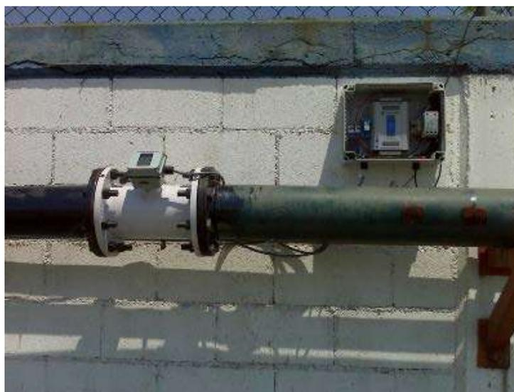
*Figura 4-16. Ejemplo de estación de aforo con un medidor fijo en un sector hidrométrico para registro de caudal continuo.*
