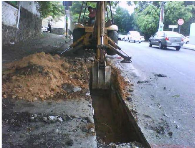
*Figura 4.13.c. Excavación de zanja con maquinaria pesada.*
