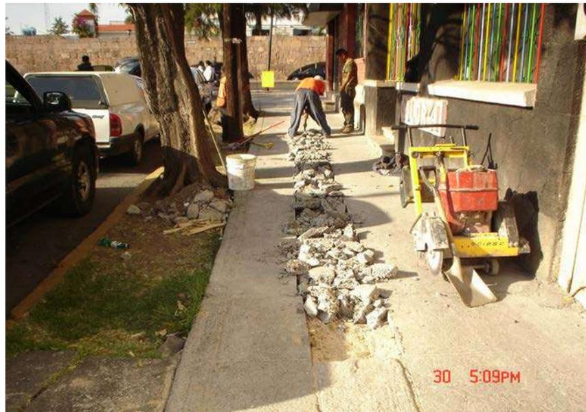
*Figura 4.13.a. Trazo, corte y demolición de pavimento.*
