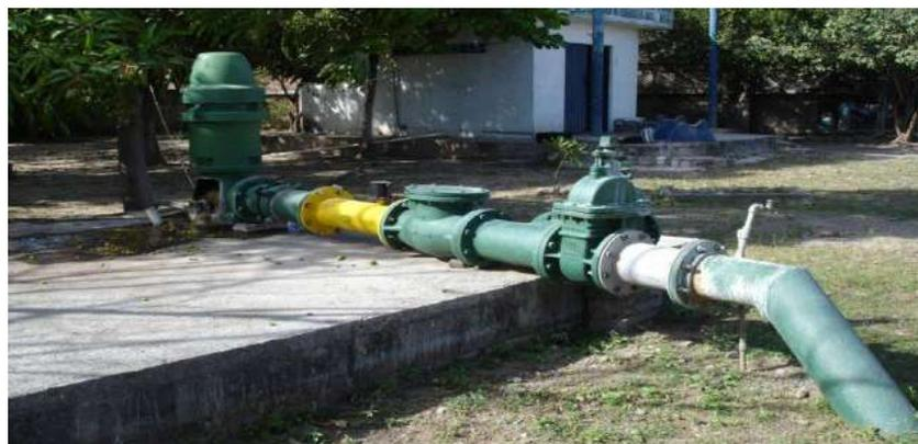
*Figura 1-6. Fuente de abastecimiento subterránea (acuífero) y obra de captación común en México (pozo profundo).*
