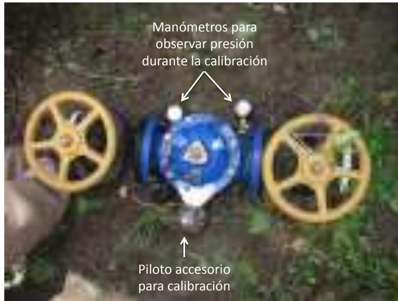
Figura 4-32. Válvula sostenedora de presión de seis pulgadas de diámetro, instalada en una derivación a la red de agua.
