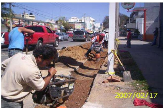
*Figura 4.13.f. Relleno de zanja y compactado con bailarina.*
