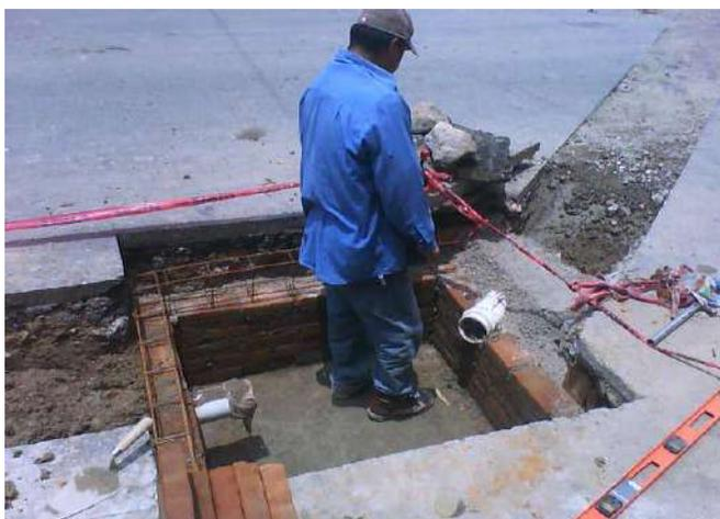
*Figura 4.13.e. Conexión de tubería.*
