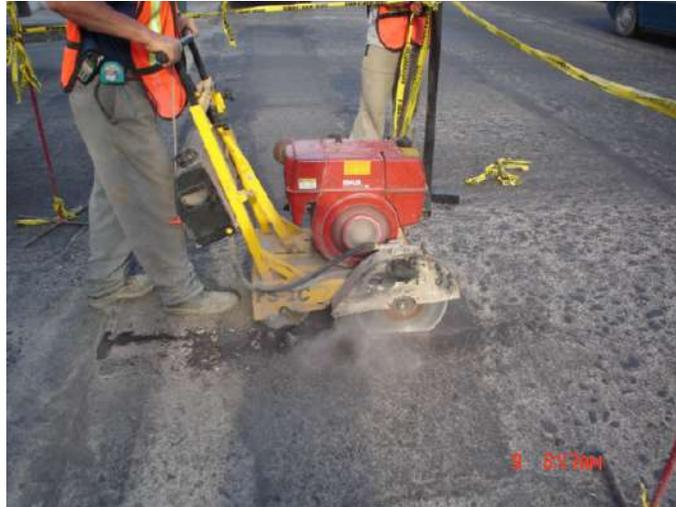
*Figura 4.11.a. Corte de pavimento.*
