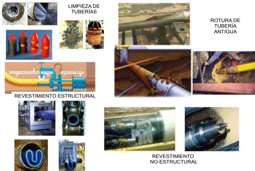
Figura 1-20. Tecnologías para rehabilitar y renovar tuberías sin hacer zanja.
