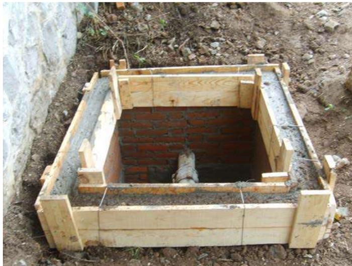
*Figura 4.11.f. Colocación de muros de tabique y armado y colado de dalas.*
