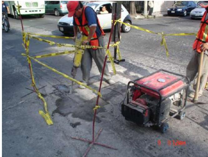
*Figura 4.11.b. Ruptura de pavimento.*
