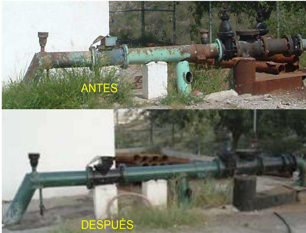
*Figura 5-32. Ejemplo de reemplazo de medidor dentro del mantenimiento a un tren de descarga de pozo en un sector de la red.*
