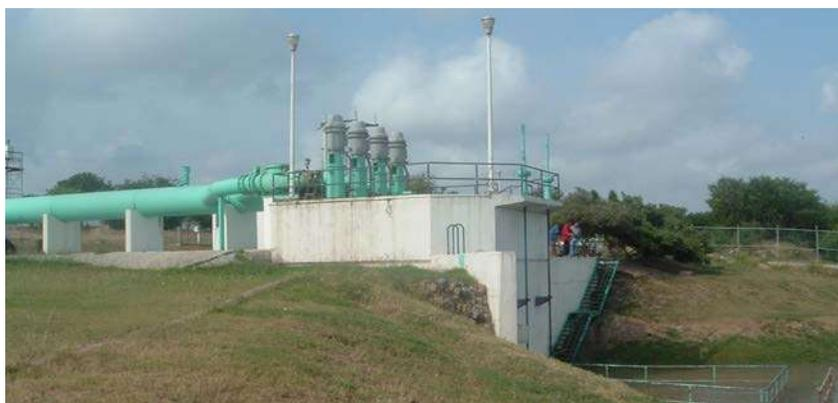
*Figura 1-5. Fuente de abastecimiento superficial (río) y obra de captación común en México (obra de toma).*
