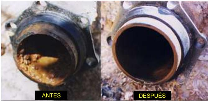
Figura 1-16. Tubería rehabilitada por desgaste interno.
